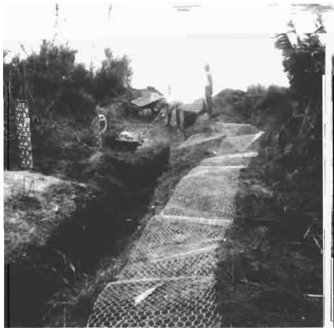
Installation du tube de cuivre Ikopa à Bevomanga
