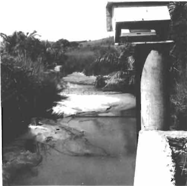
Photo n° 3 Limnigraphe Ott à flotteur installé sur un seuil de mesure B. V. Expérimental d'Ambodiroka.
