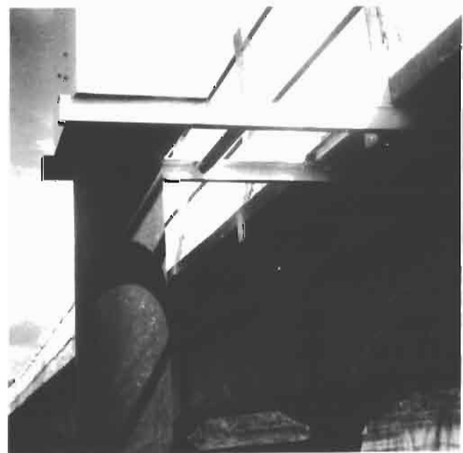
Photo n° 12 Détail fixation cabine (Andromba au pont route Arivonimamo).
