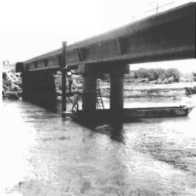
Photo n° 5 Installation d'un limnigraphe à flotteur sur un pont dont les piles sont fortement en retrait par rapport au tablier (Ikopa au Pont de Mahitsy).
