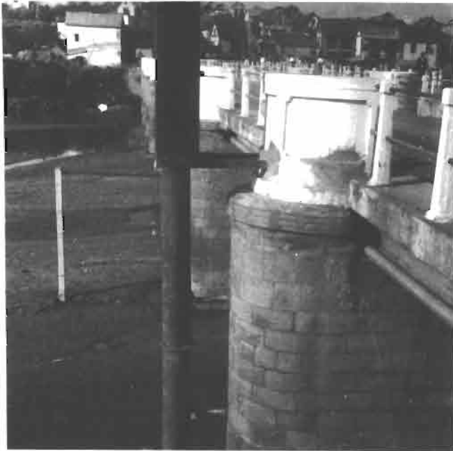
Photo n° 1 Installation d'un limnigraphe Richard à flotteur sur une pile de pont (Sisaony à Ampitatafika).
