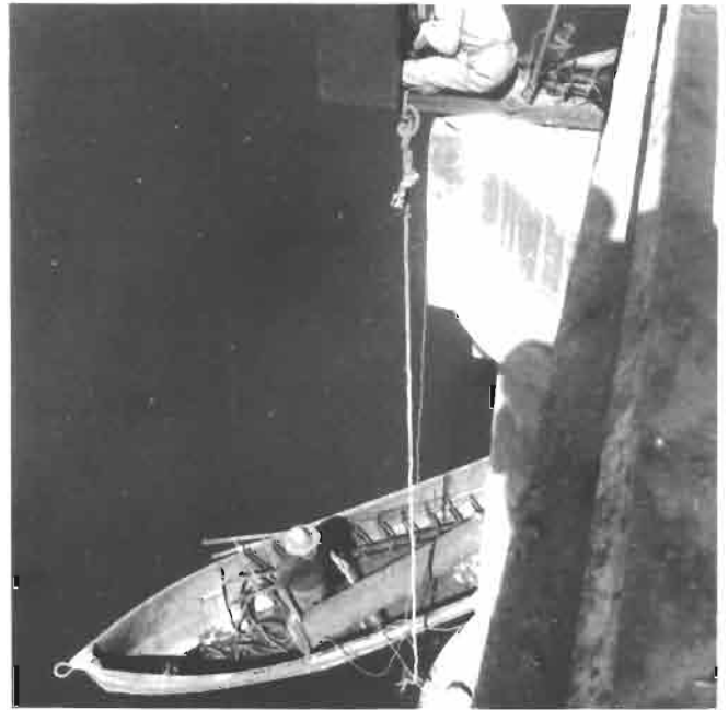
Photo n° 2 Installation d'un limnigraphe Richard sur une pile de pont (Ikopa à Anosizato).
