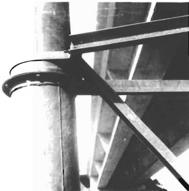
Photo n° 7 Détail de la fixation du tube à la pile (Ikopa au Pont de Mahitsy).
