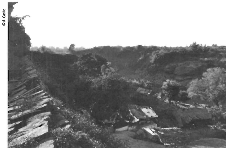
Restes d'un barrage après rupture (11 e siècle), Bhojpur, non loin de Bhopal (Madhya Pradesh, district de Raisen).
