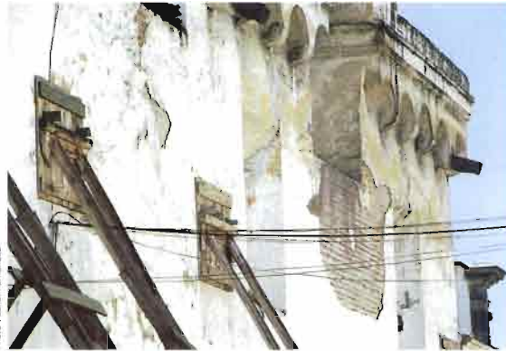
Après le séisme de 1987, consolidation en cours d'une maison en briques.
