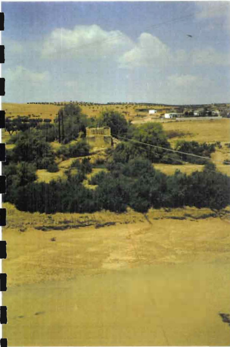
Station hydrométrique de la Sloughia à l'ancien pont emporté en 1973, 13/6/95 (photo Ramette)
