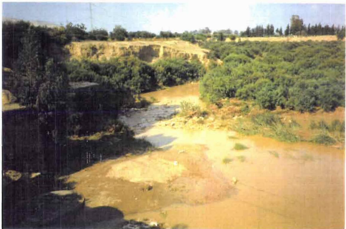
Pont-barrage d'El Bathan, vue vers l'aval 13/6/95 (photo Ramette)
