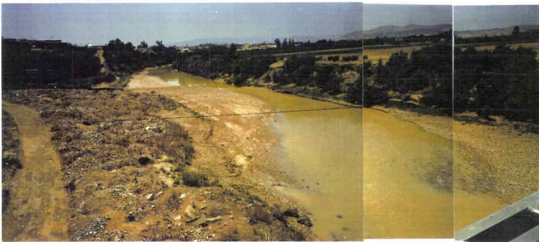
Pont de Testour sur la Medjerdah, vue vers l'amont 13/6/95 (photo Ramette)
