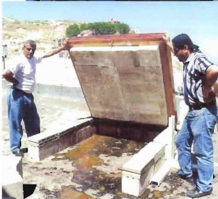
Isolation inférieure par 10 cm de polystyrène
