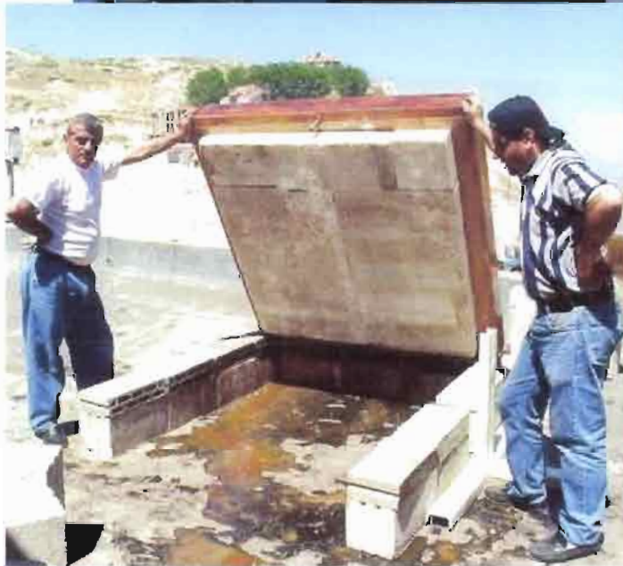
Isolation inférieure par 10 cm de polystyrène
