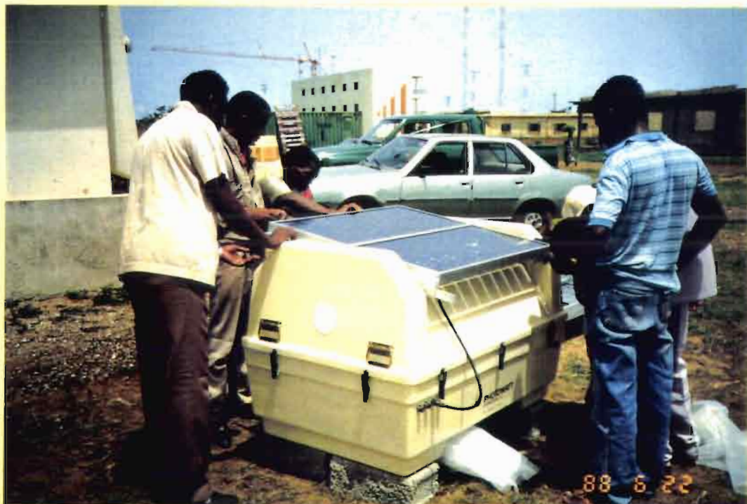
MONTAGE DES PANNEAUX SOLAIRES
