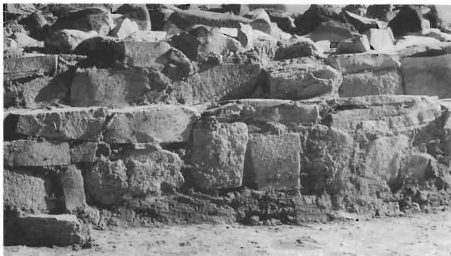
Fig. 8. Zona XXIII-A: detalle de la construcción.
