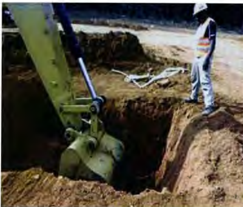
Figure 4 : Monitoring d'engins de terrassements
