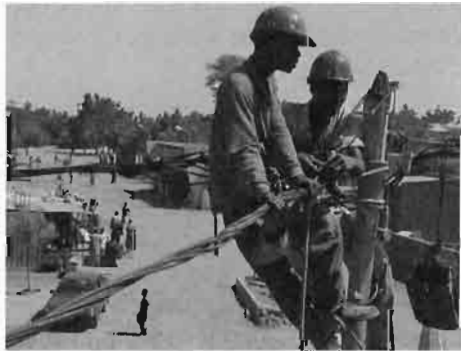
Deux apprentis-électriciens de Nioro-du-Sahel équipent un pylône sur la place du marché. (© C. Lallier, novembre 1997)
