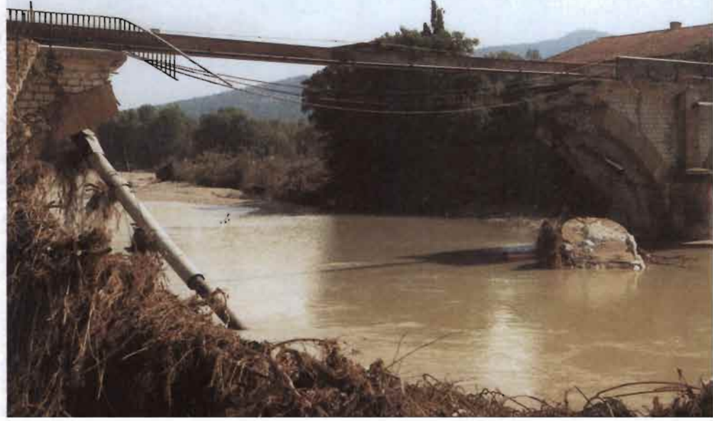
Dégâts de la sécheresse ici, dégâts des eaux ailleurs: Vaison-la-Romaine (septembre 1992).
