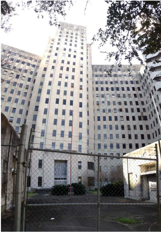
Photo 1 – façade et entrée principale de l'hôpital, 19 février 2015, Fanny Chabrol©
