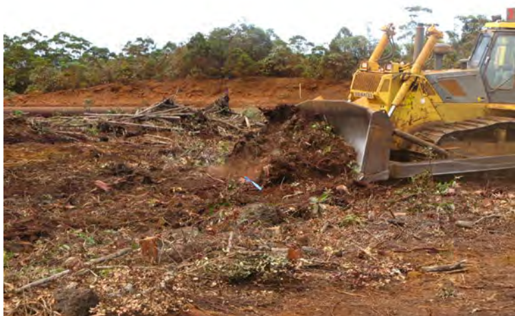
Figure 10 : Récupération du topsoil après décapage
