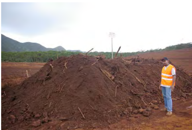
Figure 13 : Topsoil en andain de 2 m
