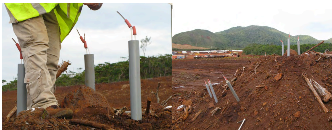
Figure 101 : Pose des bougies poreuses sur la pile expérimentale de TOPSOIL le 10 août 2011
