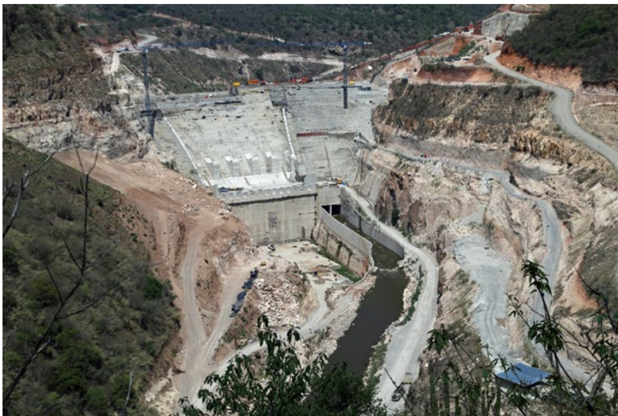
Le chantier du barrage du Zapotillo
