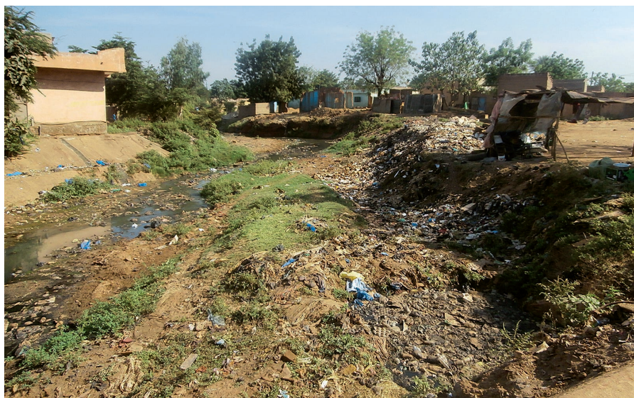
Figure 9. Lit encombré de l'un des deux cours d'eau ayant débordé et inondé le quartier de Banconi à Bamako le 28 août 2013.
