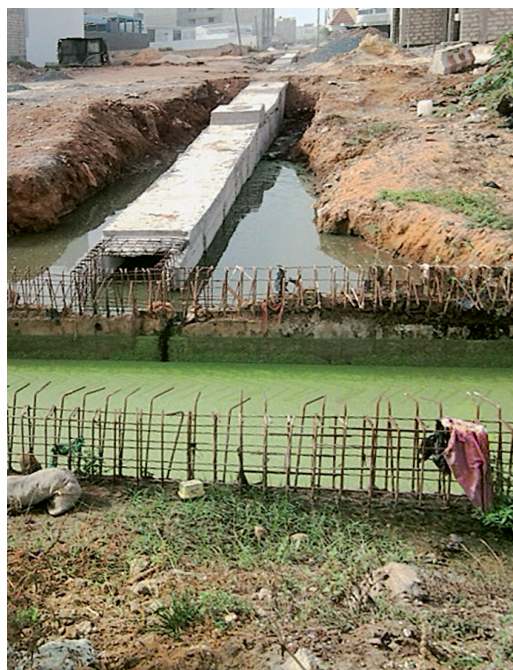
Figure 10. Creusement des drains dont l'absence a provoqué l'inondation du quartier Ouest Foire à Dakar le 26 août 2012 (photo décembre 2013).
