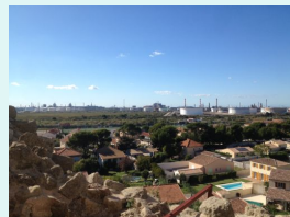
Le front industriel à Fos-sur-Mer, vu depuis l'Hauture (2015)
