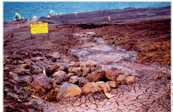
Figure 1.9 : Zone de décapage à Goro.
