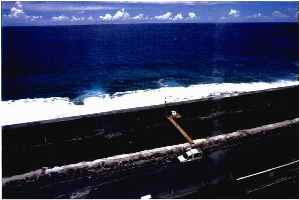
Planche 1: Vue aérienne du forage P7 réalisé en Novembre 1992 au niveau de la digue en béton (6m) érigée en 1965. Une passerelle permet de traverser le fossé d'évacuation des houles. Le tube de forage débouche sous la guérite de mesure.
