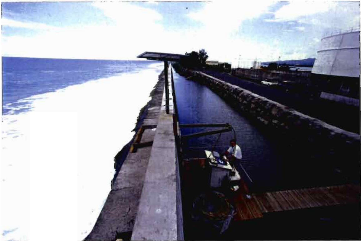
Planche 1 : Vue du forage P7 équipé d'une plate-forme, d'une potence, d'une alimentation électrique solaire et d'une guérite d'instrumentation. Noter la présence du polytube de prélèvement sur la plate-forme.
