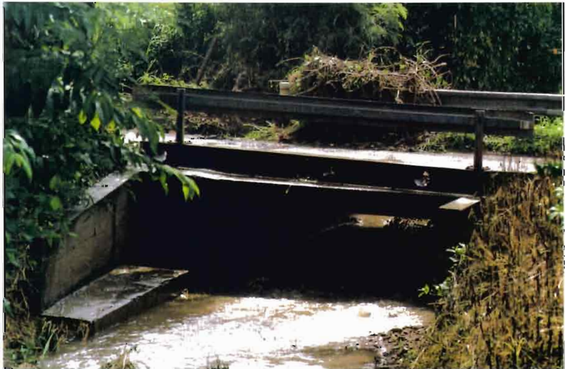
Ouvrage principal sur la ravine Blanche – Vue de l'aval
