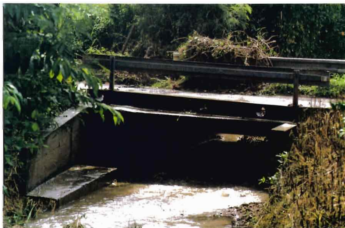
Ouvrage principal sur la ravine Blanche – Vue de l'aval
