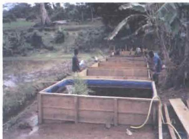
Fig. 4.- Schéma de bac en bois bâché de volume = 6 m<sup>3</sup>
