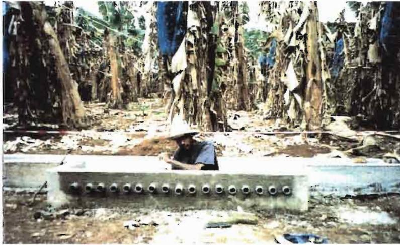
**Photo 3 – Construction des partiteurs au sommet du piège à sédiments à l’aval d’une future parcelle d’érosion (01/1999).**
