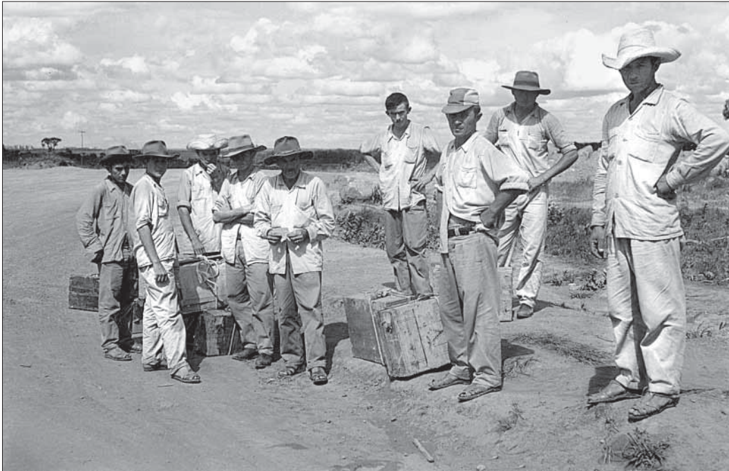
Groupe d'ouvriers arrivant sur le site du chantier du Plano Piloto en 1959.
