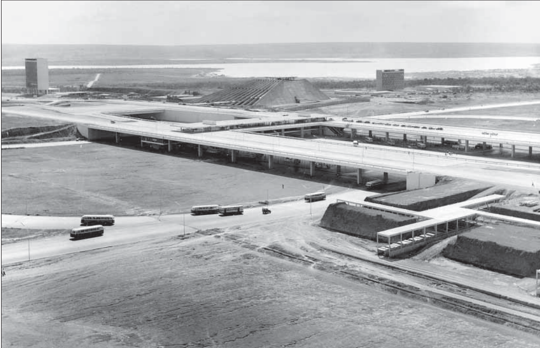
La gare routière en construction en 1963.
