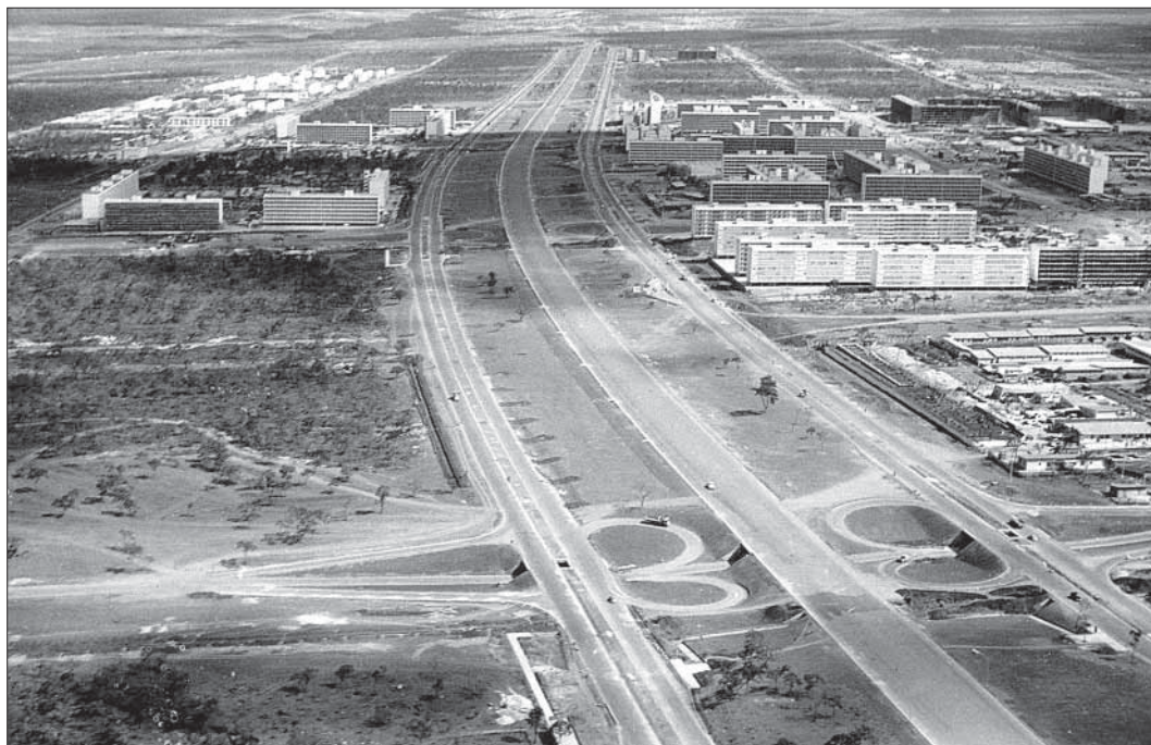
Axe routier Sud, aile sud du Plano Piloto en 1959.
