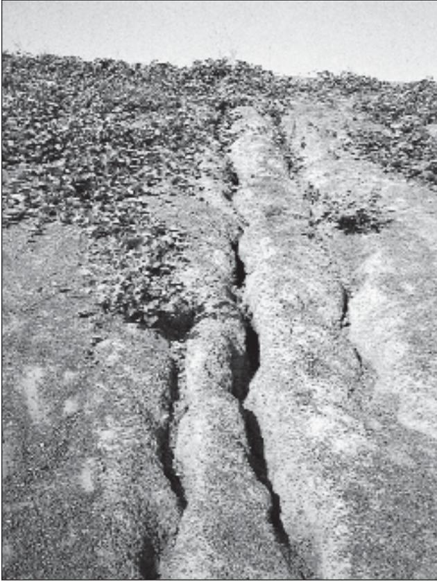
**Ravines creusées par l'érosion pluviale sur la digue du barrage de Kaoura, au nord de Ouangolodougou.**
