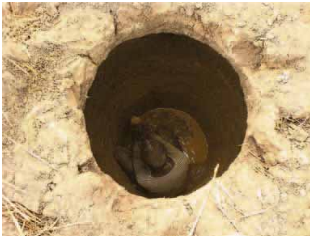
Approfondissement d'un puits à l'aide d'une calabasse au Ghana.
