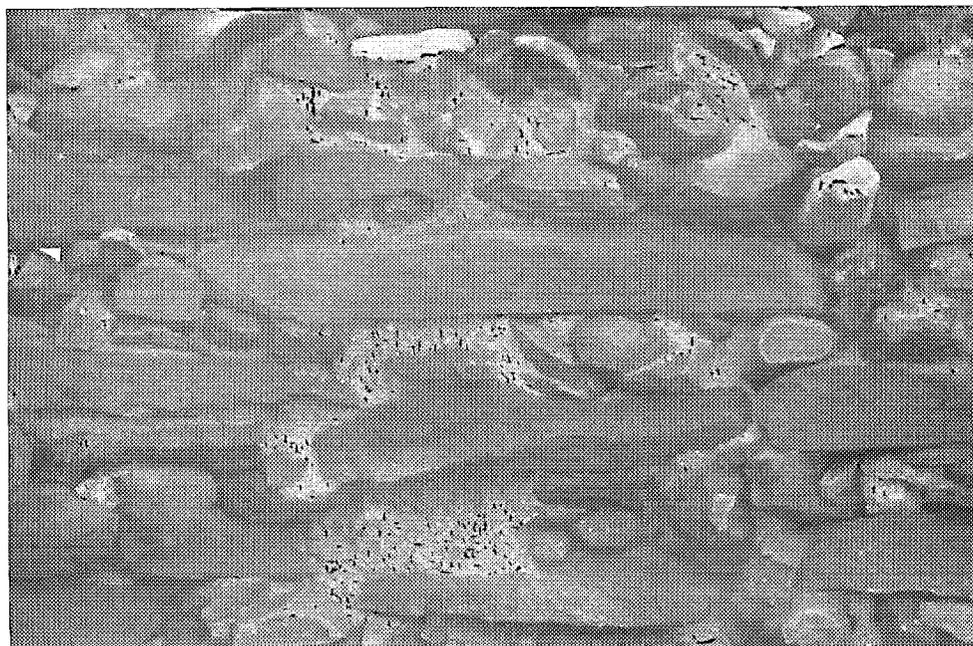
Photo 2. — Détail d'un mur intérieur où est bien visible le mortier liant les assises d'un appareil alterné. Les pierres utilisées proviennent de la fragmentation naturelle des roches cristallines avoisinantes.
