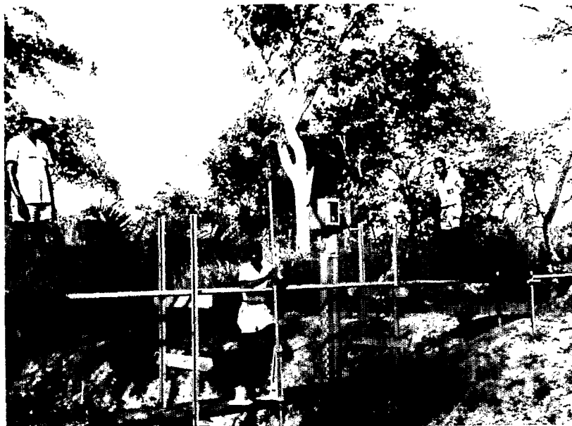
Fig. 4. — Passerelle de jaugeage et limnigraphe sur la Lhoto.
