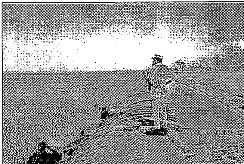
Canal d'irrigation secondaire avec siphons
