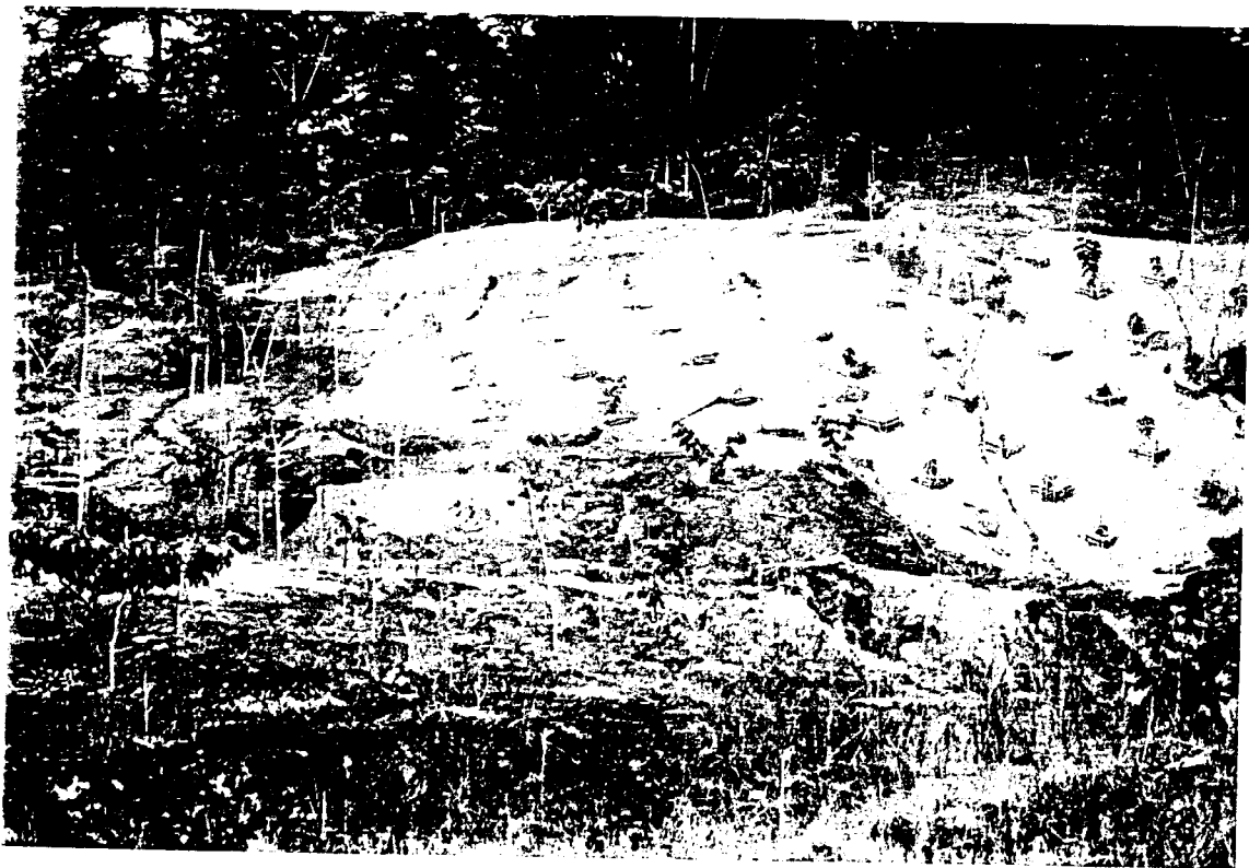
Photo 8. Tentative de mini-terrassements pour fixer le talus (Cl. Y. Barthélemy)
