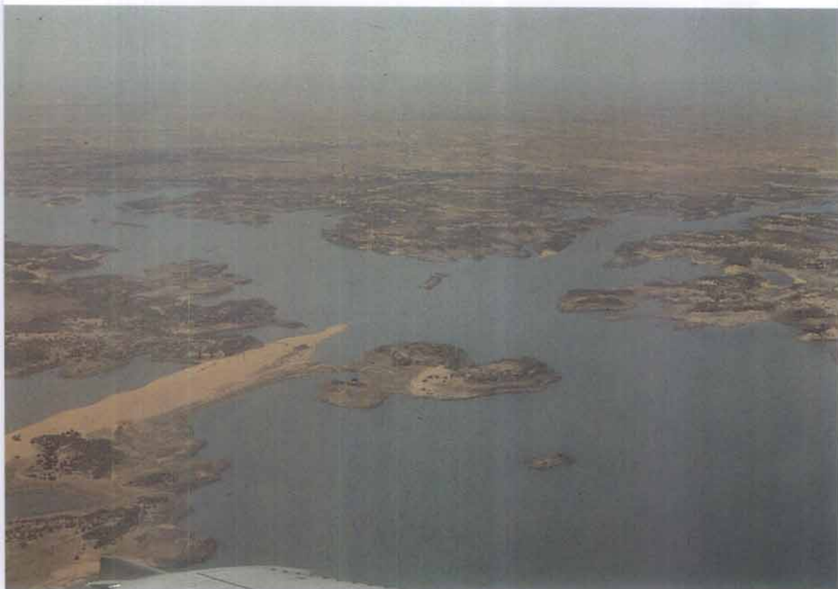
La construction du haut barrage d'Assouan entraîna, en 1963-1964, le transfert de plus de 100 000 Nubiens qui vivaient de part et d'autre de la frontière soudano-égyptienne. (Photo Véronique Lassailly-Jacob)
