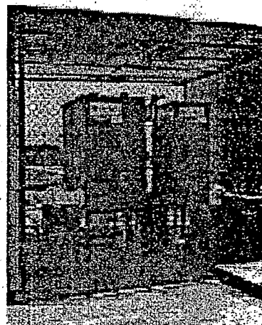
Fig. 1 Biofiltro para el tratamiento de los vapores de campanas de extracción de solvente instalado en la UAM-I
