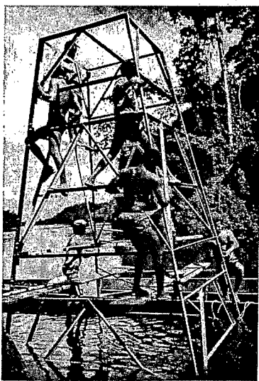
Figure 4 : Montage d'une tour limnigraphique à Langatabiki (fleuve Maroni) en Guyane. Station appartenant au réseau hydrométrique depuis 1950 (photo M. Lointier).
