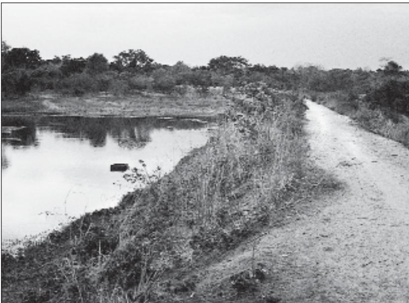
**Barrage à vocation pastorale typique édifié par la Sodepra dans les années 1980 : une digue en terre compactée retient une partie des écoulements d'une rivière temporaire durant la saison des hautes eaux. L'évacuateur de crue, ou déversoir, par lequel transitent les écoulements excessifs, conditionne la capacité du réservoir. Le moine de vidange est visible.**
