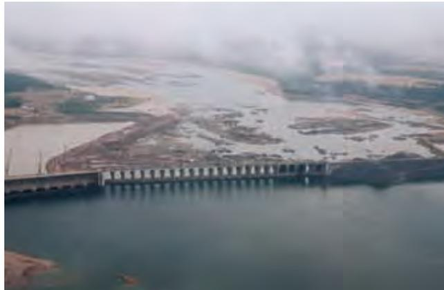
*Figura 3.2: Vista aérea do baixo Rio Tocantins à jusante de Tucuruí durante o enchimento do reservatório. A interrupção total do fluxo d'água deixou expostas grandes áreas do leito.*
