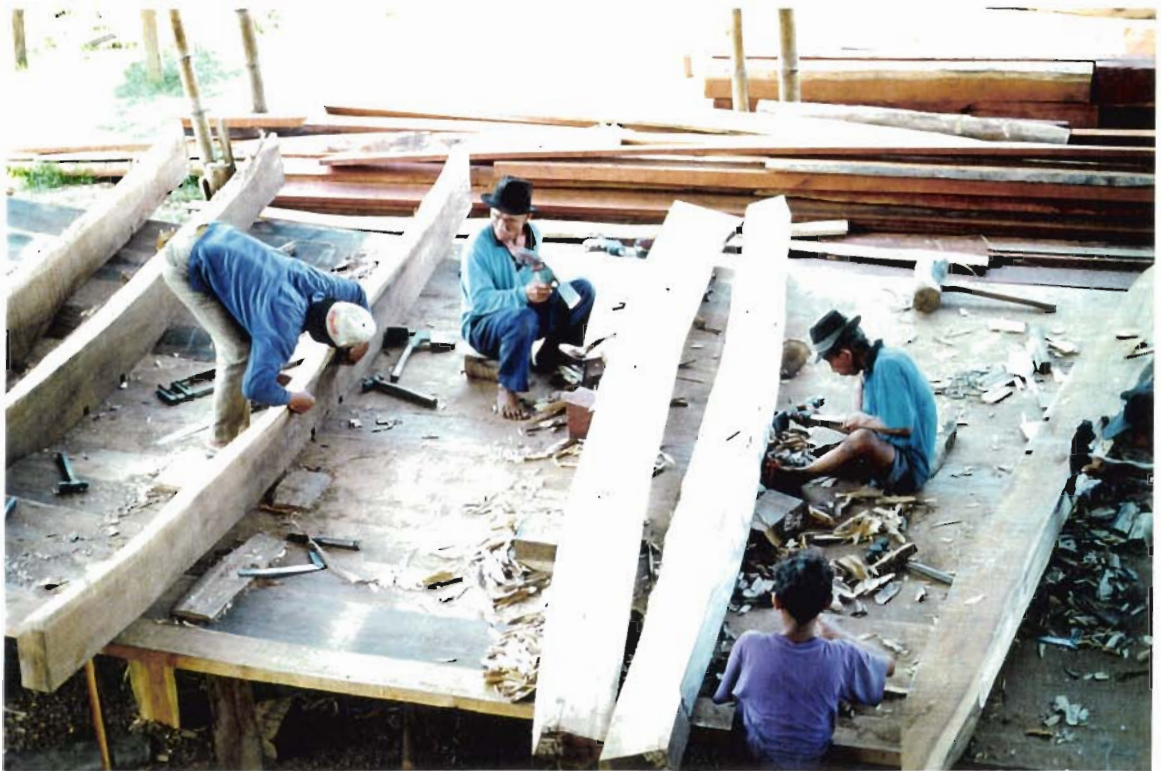
Scène de travail sur un chantier naval de Batang (Java Centre).
