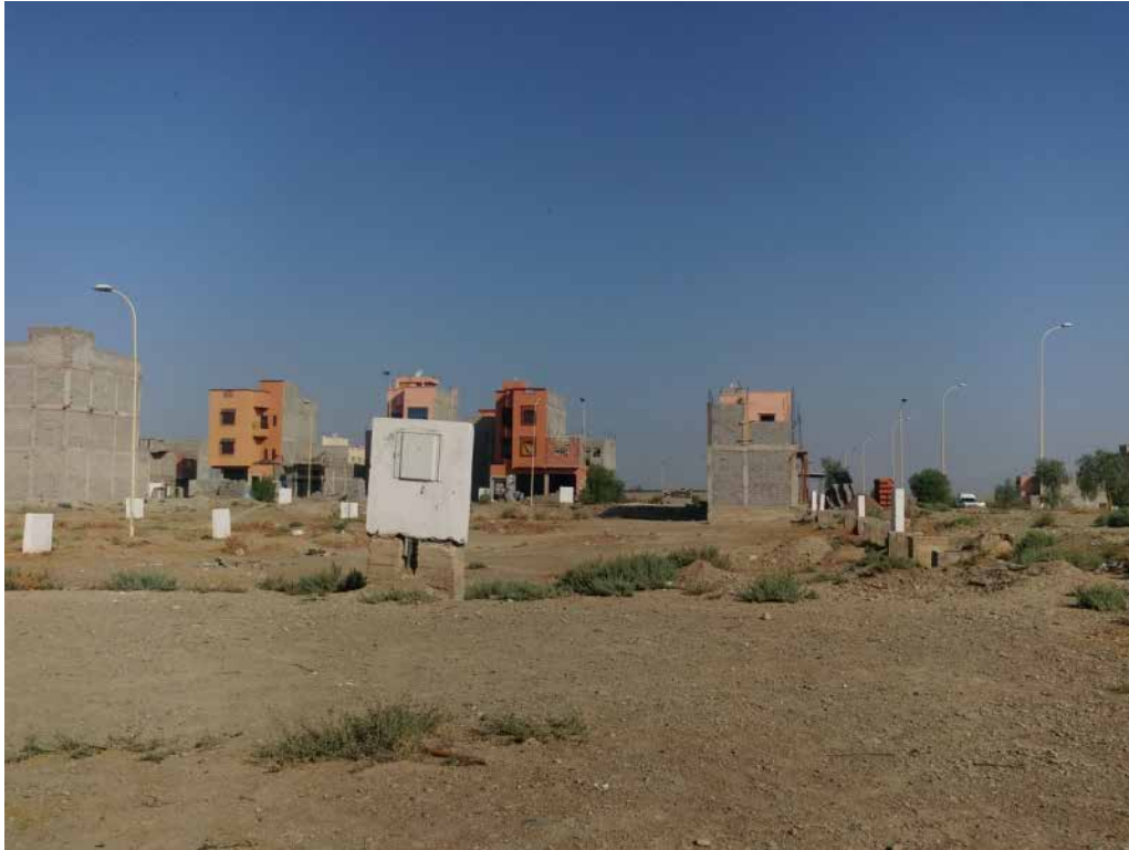
Figure 3. Secteur d'auto-production de l'habitat dans la ville nouvelle de Tamansourt : les parcelles se vendent bien et l'activité de construction est assez intense. Le profil urbain qui émerge est caractéristique de la ville informelle (Source: IRD, 2018)
