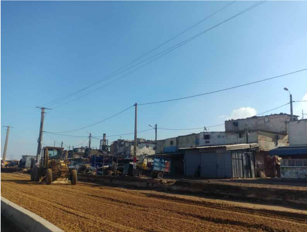
Figure 4. Chantier de construction de la voirie sur le site de Zenata . En arrière-plan, l'un des noyaux de bidonvilles que compte le périmètre de la future Eco-cité (Source: IRD, 2018)
