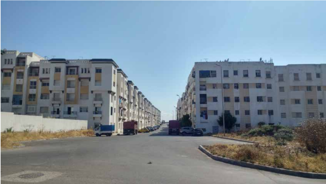
Figure 5. Quartier d'habitat collectif situé dans le périmètre de la future Eco-cité Zenata , à l'extérieur du plan d'aménagement sectoriel, pour reloger une partie des habitants des bidonvilles présents sur le site (Source: IRD, 2018)
