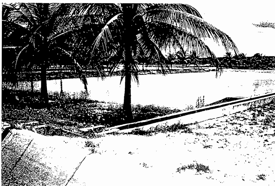
Photo D36 Açude public Poço da Cruz du DNOCS, Ibimirim, PE. Vue de l'un des 12 bassins de 80 m x 40 m (encore en eau) et des canaux d'alimentation. On note le parfait entretien des bassins (berges opposées en pentes douces cimentées).
