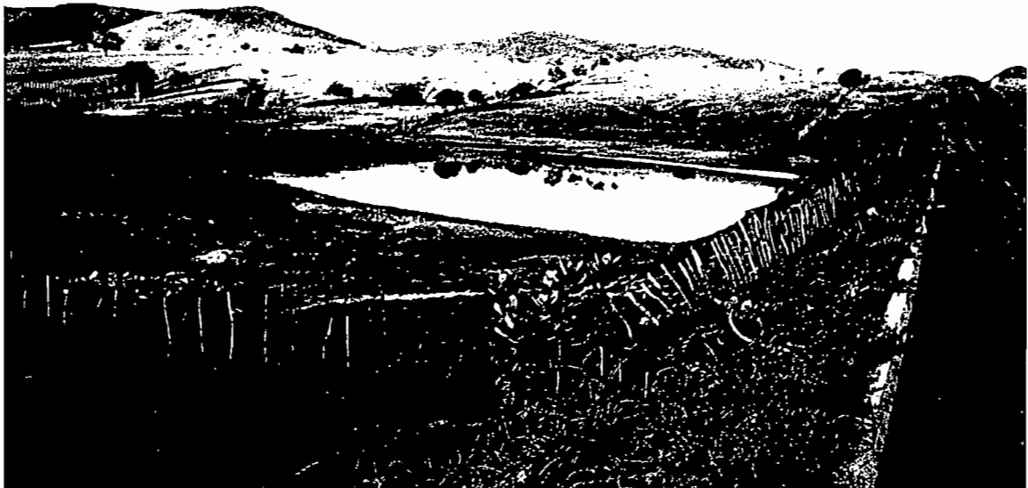
Photo C10 Petit açude le long de la BR230 entre João Pessoa et Campina Grande (PB). Le remblai de la route sert de digue pour le barrage.
