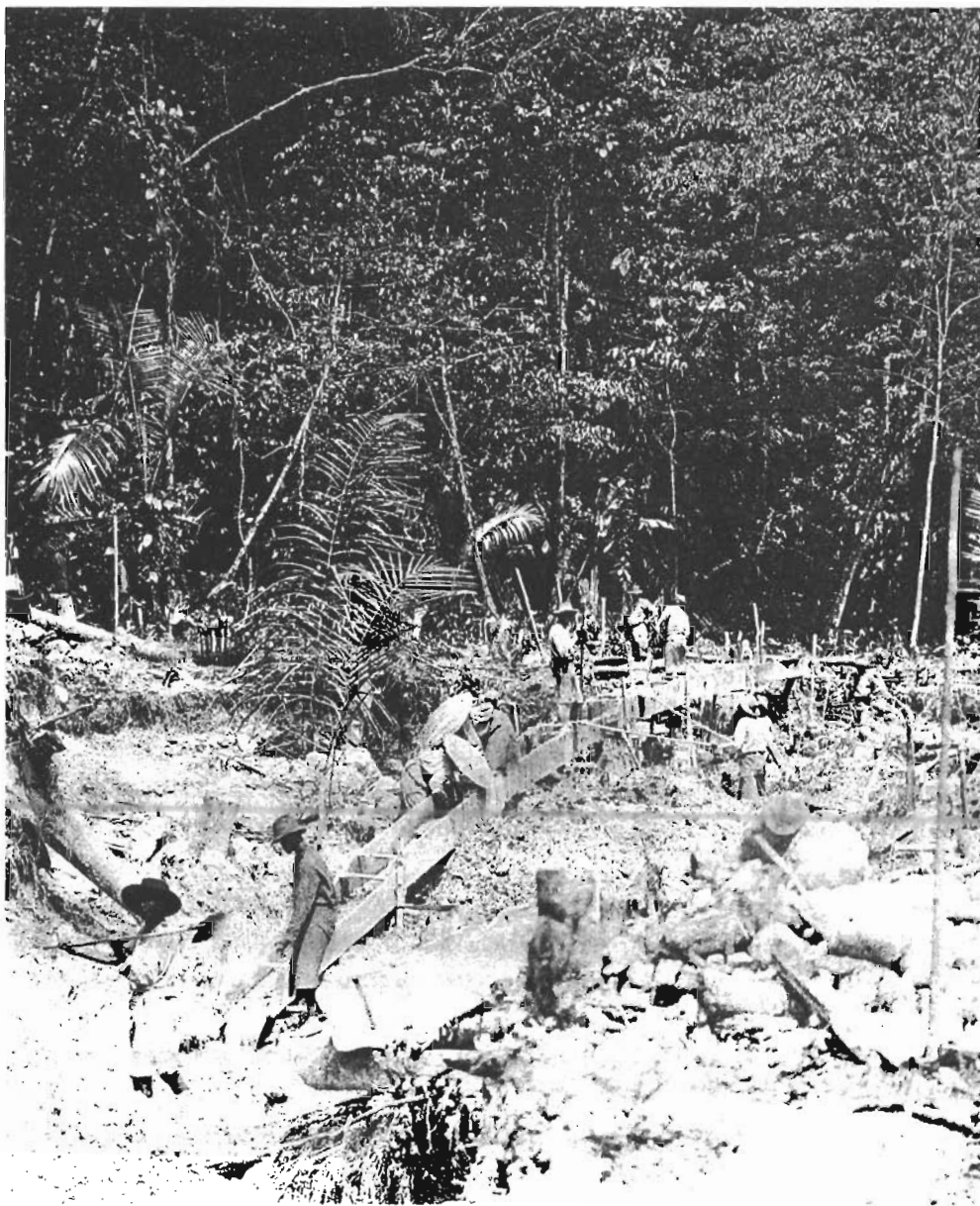
"Lavage au "sluice" des sables aurifères -Placer St-Elie", Ed. Mme Georges Evrard, N°47, Col. Bureau du Patrimoine Ethnologique.
