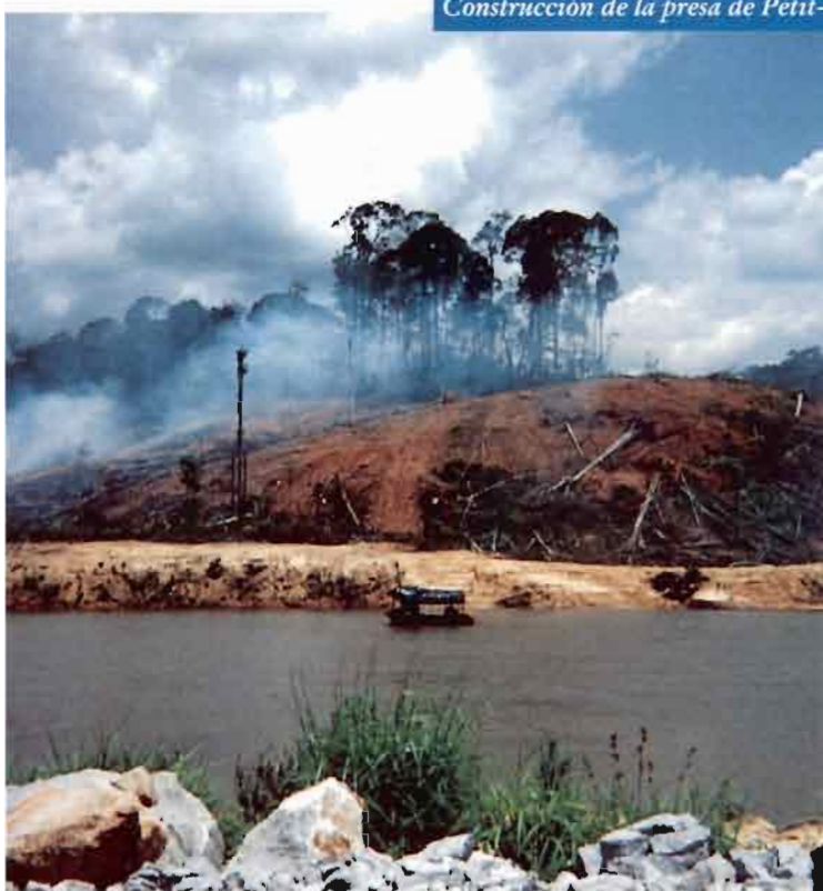
Construcción de la presa de Petit-Saut. Guyana.
