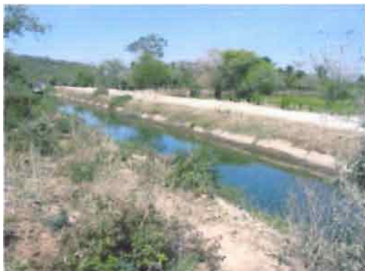
Canal primario del distrito de riego
