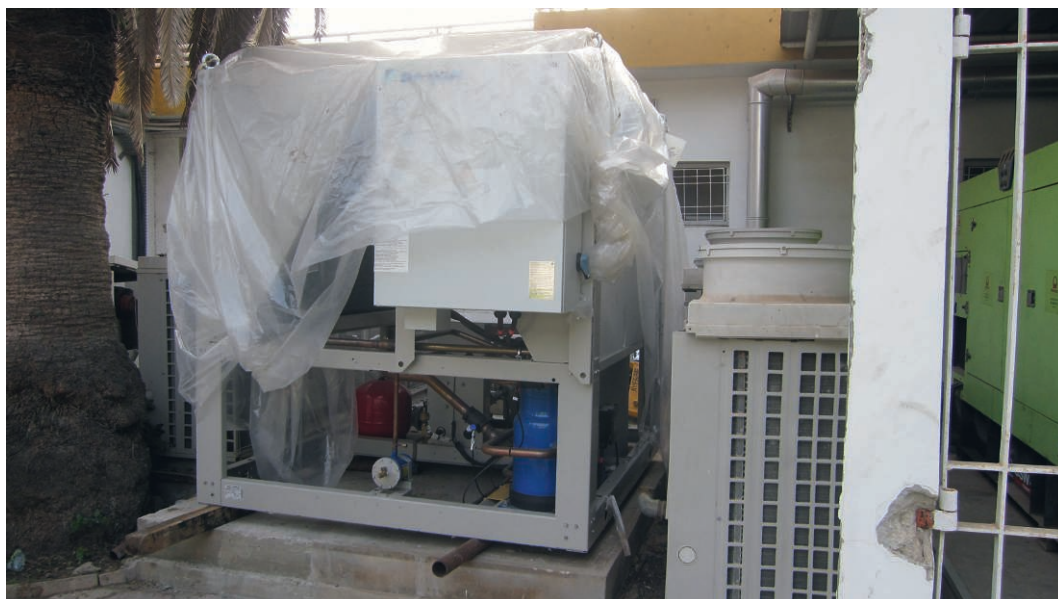
2. Recouvert d'une bâche en plastique, le nouveau groupe de froid attend d'être connecté au système de refroidissement. À sa droite, on aperçoit le groupe n°1 poussé sur le côté en attendant d'être mis au rebut.
