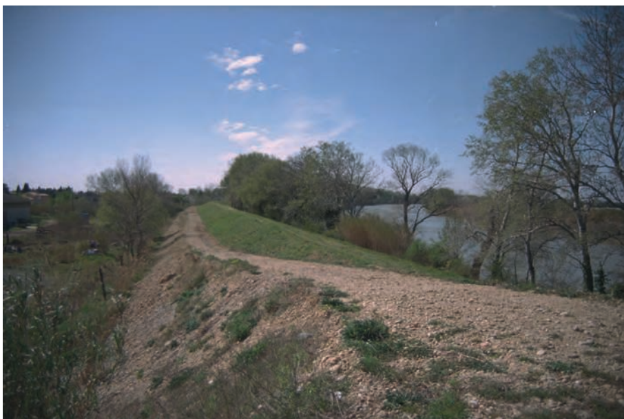
Figure 6. Dignes du Petit Rhône après confortement en Arles. (Crédits : Patrice Mériaux.)
