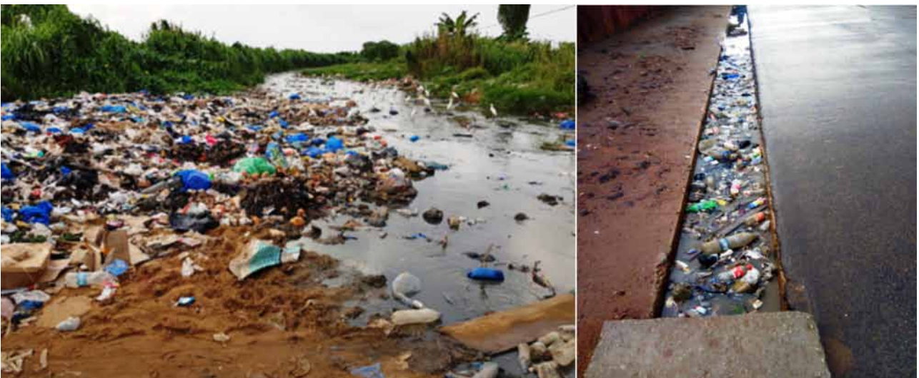
Fig. 4. Accumulation de déchets dans les réseaux d'eau intra-urbains d'Abidjan, ici à Cocody Palmeraie.
