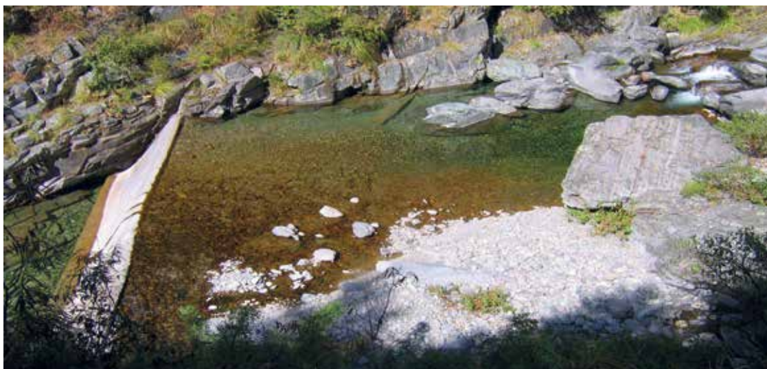
Figura 32. Obra de toma en el Rincón de La Victoria, una de las principales fuentes de agua de la ciudad de Tarija.
