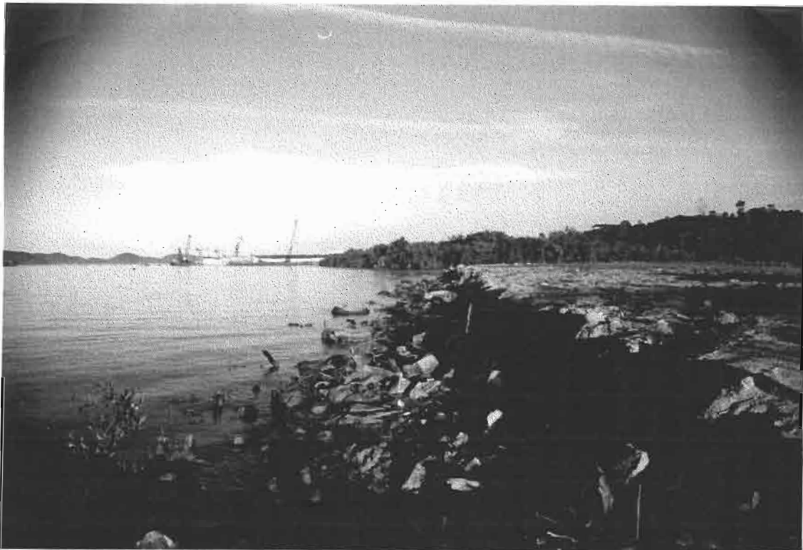
Fig. 59: Atterrement d'une surface de 1 ha sur un ancien site de mangrove, commune d'Antonina. Matériel utilisé: scories industriels. (cliché personnel, 1991).
