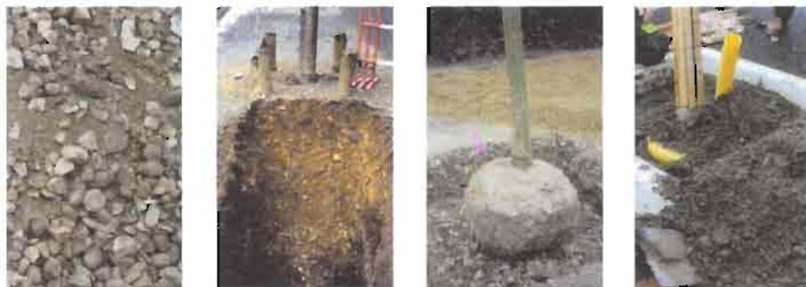
**Figure 8.11.** *Mélange terre-pierres, fosse de plantation remplie de terre-pierres, trou de plantation et mélange terre-compost de remplissage du trou (photos : J.-P. Rossignol et L. Vidal-Beaudet)*
