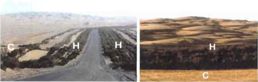
**Figure 3.18.** Méthodes de lutte contre l'érosion éolienne pour protéger la route qui traverse les 446 km de dunes vives du désert du Taklamakan, Xinjiang, Chine : une bande de quadrillages de paille de roseau (C), large d'environ 50 m, précède au moins 6 lignes des haies vives (H) irriguées à partir de la nappe et composées de plusieurs espèces adaptées aux conditions désertiques et à l'eau salée [CHE 15] (photos : C. Valentin).
