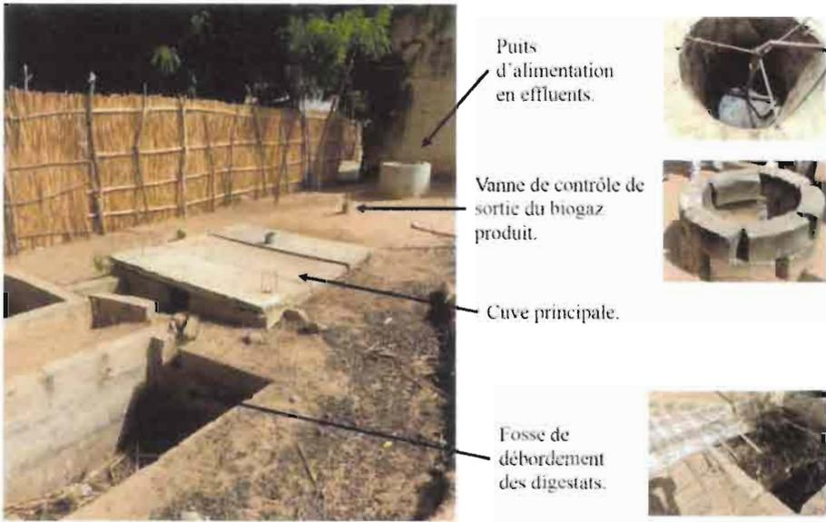
**Figure 9.2.** Biodigesteur rural domestique enterré avec, en arrière-plan, le puits d'alimentation et, au premier plan, la fosse de débordement des digestats (source : F. Feder)
