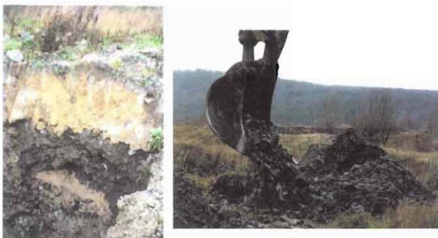
**Figure 7.1.** Sols de friches industrielles contaminés par des hydrocarbures
