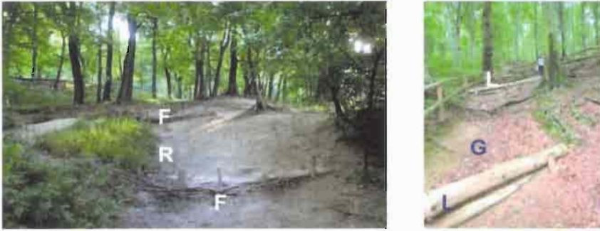
Figure 3.19. Méthodes de lutte contre l'érosion concentrée. À gauche : une succession de fascines (F) retient des sédiments d'une rigole (R), parc Zamok, Lviv, Ukraine. À droite : des rondins (L) ont été installés en travers d'une petite ravine (G) formée à partir d'un sentier dans la hêtraie, Chojnik, Pologne (photos : C. Valentin).
