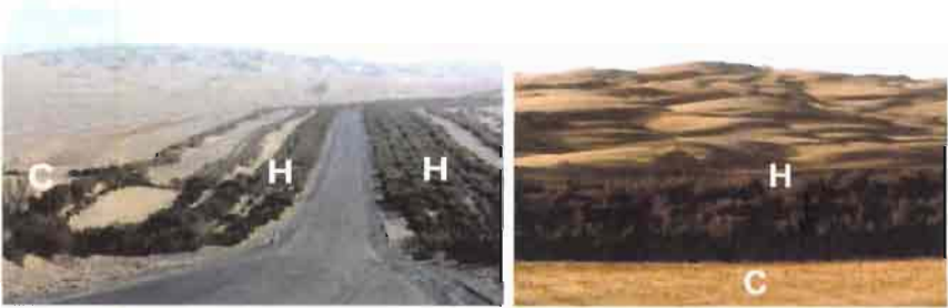
Figure 3.18. Méthodes de lutte contre l'érosion éolienne pour protéger la route qui traverse les 446 km de dunes vives du désert du Taklamakan, Xinjiang, Chine : une bande de quadrillages de paille de roseau (C), large d'environ 50 m, précède au moins 6 lignes des haies vives (H) irriguées à partir de la nappe et composées de plusieurs espèces adaptées aux conditions désertiques et à l'eau salée [CHE 15] (photos : C. Valentin).
