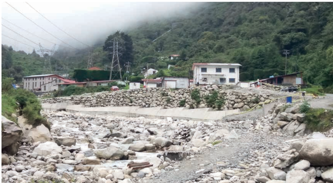
Figura 35. Central hidroeléctrica Cuticucho en Valle de Zongo, 2020.
