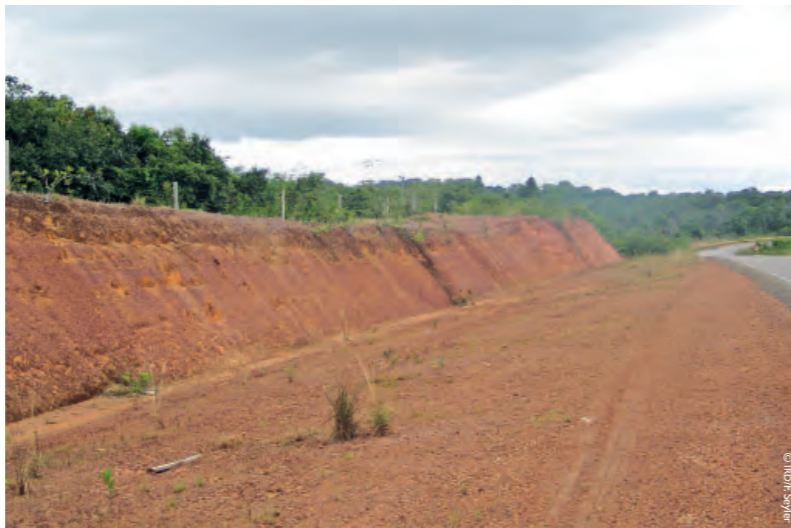
Corte de estrada em lateritas na BR 174 entre Boa Vista e Caracará, Brasil.
