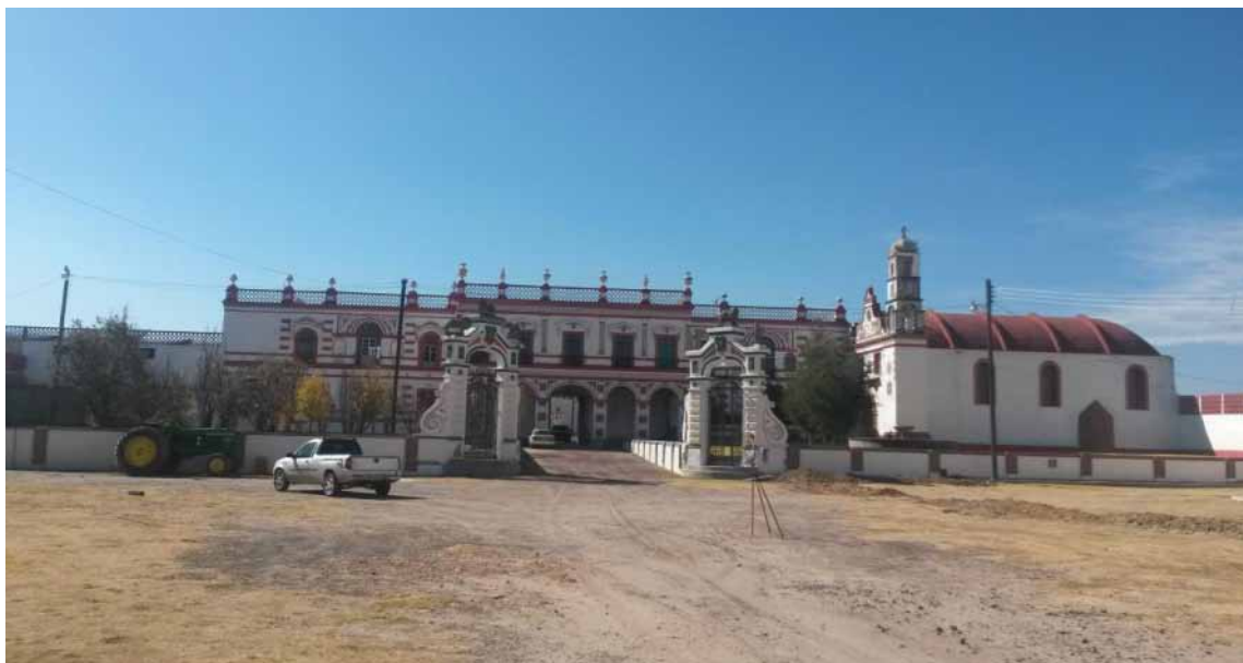
Photographie 1. Ex-hacienda San Bartolome del Monte
