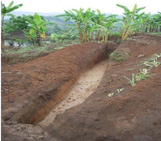
Photo 3 : Fossé de retenue d'eau ruisselant sur les chemins, les toits et les cours des maisons
